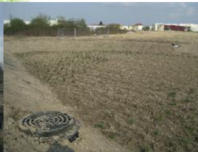
bassin filtrant pour réceptionner les eaux pluviales avant rejet dans la rivière
