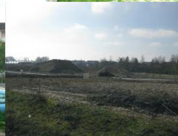
Début du chantier, plantation d'arbres
