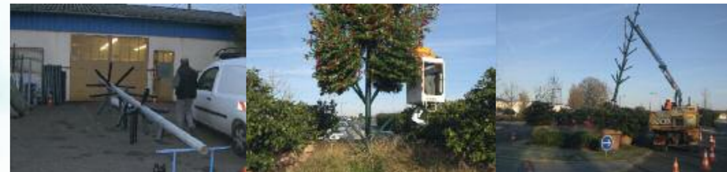
Fabrication et installation d'un mât-sapin
